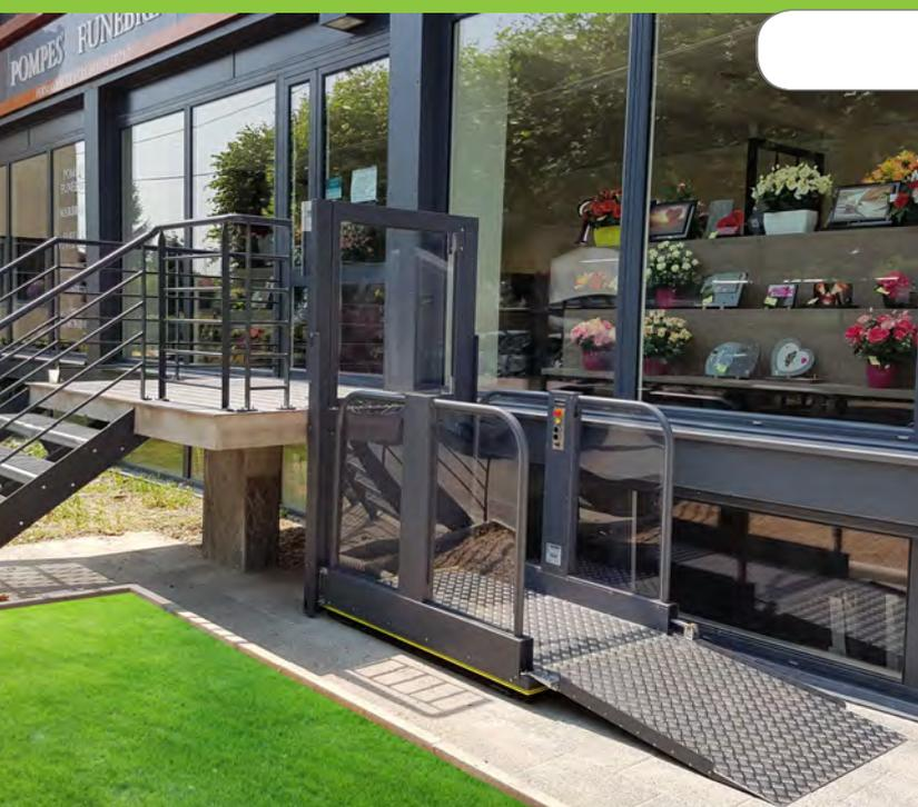
La plateforme élévatrice V130 est conçue pour transporter des fauteuils roulants et des passagers en toute sécurité pour des différences de hauteur allant jusqu'à 1 m 30. Elle est dotée d'un design moderne avec ses parois latérales et son portillon supérieur en verre de sécurité.
